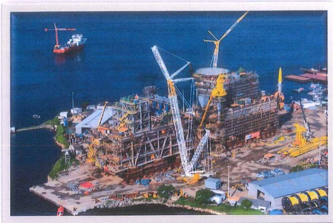
Fig. 6. Módulos de Processo (4.400 ton) e Utilidades (5.180 ton) da Plataforma PMXL-1 em construção.
