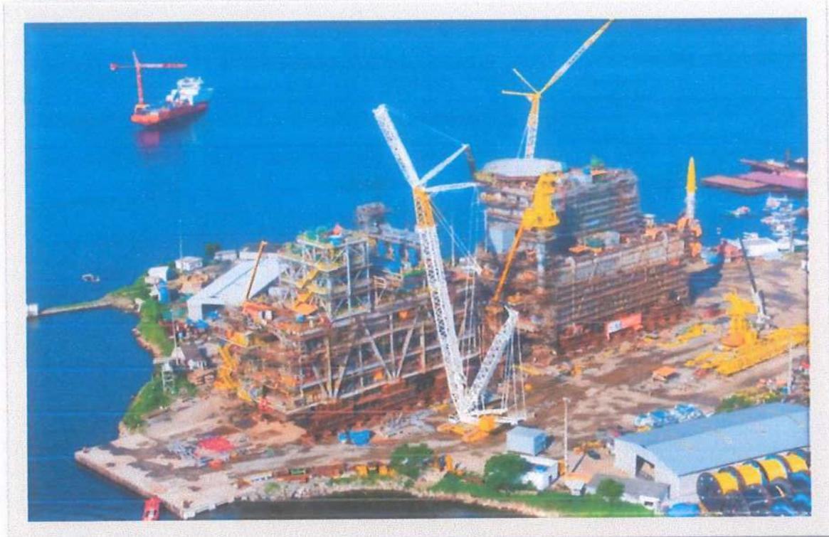
Fig. 6. Módulos de Processo (4.400 ton) e Utilidades (5.180 ton) da Plataforma PMXL-1 em construção.
