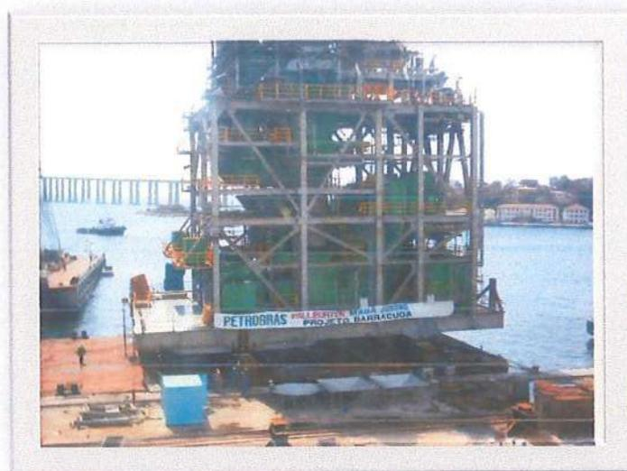
Fig. 5. Módulo de Geração (1.400 ton) do FPSO P-43 após load-out no cais I do Estaleiro Mauá.
